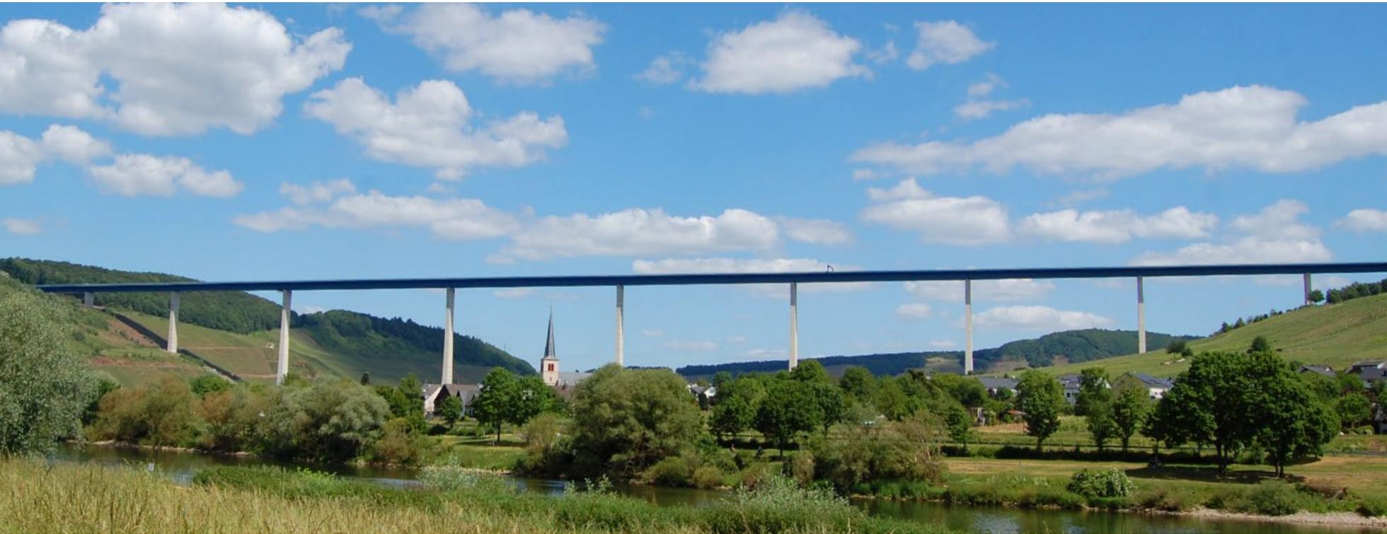
Das bundesweit zweithöchste Bauwerk, das im Kreis Bernkastel-Wittlich an der Mosel entstanden ist, ist ein Projekt der Superlative. In einer Höhe von rund 160 Metern spannt sich die Hochmoselbrücke bei Zeltingen-Rachtig 1,7 Kilometer lang über das Moseltal. Die Fahrbahn auf der Brücke liegt so hoch, dass sie sogar den Kölner Dom überragen würde.
