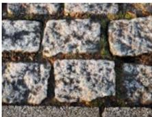
Für den Ersatz der Fahrbahnschwellen auf der zweiten Kreuzung wurde daher nach einer Lösung gesucht, die deutlich schneller zu verwirklichen ist. Man entschied sich für eine Plateauausführungsvariante mit Gussasphalt, bei der die gepflasterte Optik durch eine besondere Prägetechnik entsteht.
