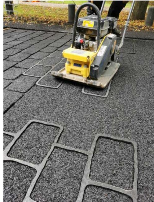
Da auch die Fahrbahndeckschicht im kompletten Kreuzungsbereich schadhaft war, sollte sie im gleichen Bauabschnitt ebenfalls mit Gussasphalt erneuert werden. Der querende Parkweg wurde dabei mit hellem Quarzsand abgestreut, so dass er sich optisch von der Straße abhebt. Für das gesamte Bauvorhaben war die Kreuzung gerade einmal drei Tage gesperrt.
