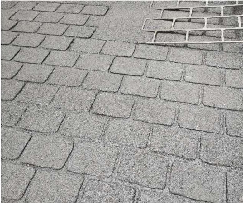
Um eine möglichst gleiche Optik wie bei der Pflasterfläche zu erhalten, wurde das großformatige Natursteinpflaster abfotografiert, eingescannt und mittels Laserstrahl aus Metallplatten herausgeschnitten. Die Besonderheit dieser Prägeschablonen besteht in der Optimierung ihrer Form, so dass sie »steinübergreifend« verwendet werden konnten.
