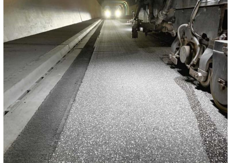
Die Gussasphaltrandstreifen wurden mit abgestumpfter Oberfläche hergestellt. Die zwischen den Randstreifen maschinell eingebaute Gussasphaltdeckschicht erhielt eine planmäßige Überhöhung von 5 Millimetern. Durch das Grinding wurden diese 5 Millimeter wieder abgetragen und höhengleich zu den Randstreifen eine wasserableitende Ebene erzeugt.
