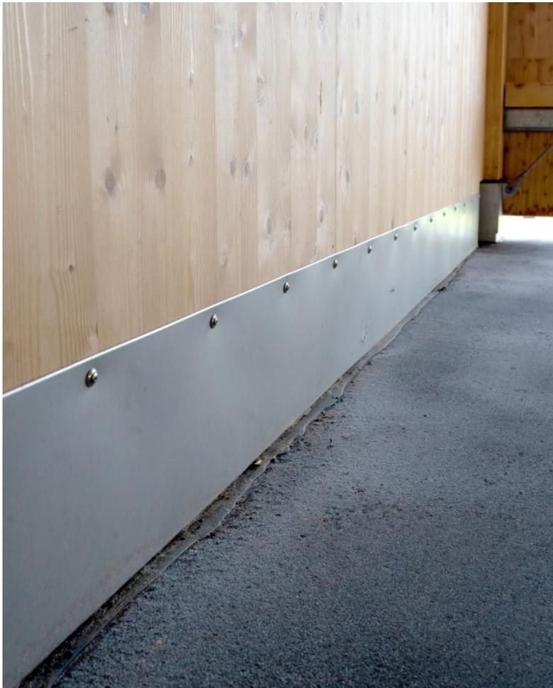
Die flächige Abdichtung des Holzbodens besteht aus einer zweilagigen Polymerbitumenbahnenabdichtung, die obere mit hochliegender Trägereinlage. Auf diese wurden insgesamt ca. 180 Tonnen Gussasphalt als Schutz- und Nuttschicht zweilagig eingebaut und mit Quarzsand abgerieben. Die Bauzeit des gesamten Parkhauses lag bei fünf Monaten mit Erdarbeiten und Rampen.
