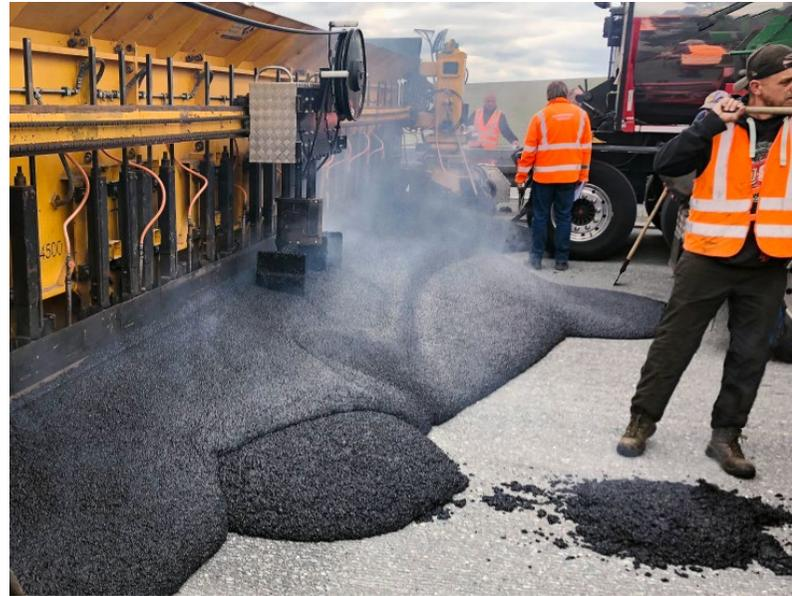
Beim maschinellen Einbau wird der Gussasphalt in Rührwerkskochern von der Asphaltmischanlage zur Einbaustelle gebracht. Diese fahren dann rückwärts bis kurz vor die Einbaubohle heran, so dass der Gussasphalt direkt vor der Bohle zur weiteren Verarbeitung ausgelassen und dann von ihr verteilt und höhenge- recht eingebaut werden kann.
