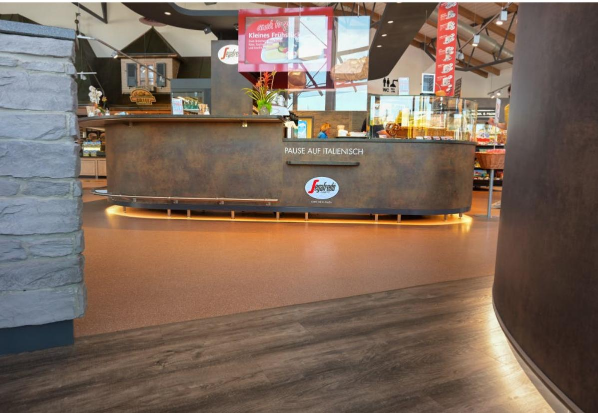
Die Besonderheit im Einbau lag darin, dass die sehr breite Fläche geteilt werden musste. Um die leichten Farbunterschiede zwischen den Flächen, die sich bei einem natürlichen Baustoff automatisch ergeben, optisch aufzufangen, wurde eine Messingschiene als Trennlinie eingebaut. Die edlen Metallschienen passen hervorragend zum geschliffenen Gussasphalt und werten den Boden zusätzlich auf.
