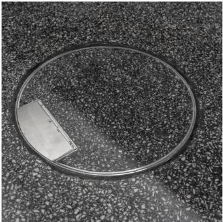
Der eingesetzte »Hofmeister Terrazzo lithos« ist ein oberflächenfertig geschliffener Gussasphaltestrich. Er wurde auf einer Fläche von 14 250 Quadratmetern schwimmend verlegt und zusätzlich im Erdgeschoss, den Fluren und in der Mensa, auf 2750 Quadratmetern, mit einer Fußbodenheizung versehen. Als Gussasphalt wurde ein IC 10 mit der Gesteinskörnung 0/5 benutzt und speziell für die Nutzung mit Fußbodenheizungssystemen ein ICH 10.
