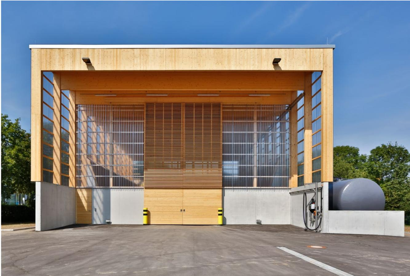
Gussasphalt ist der ideale Nutzbelag für Salzlagerhallen, da er genauso wie die Holzbauteile völlig unempfindlich gegenüber der Beaufschlagung von Chloriden ist. Hier ist der Gussasphalt aber nicht nur ein Nutzbelag zur Lagerung von Streusalzen, sondern auch ein verschleißfester Belag, ausgelegt für die Nutzung mit Radladern, Streufahrzeugen oder schweren Baumaschinen. Also eine Kombination als Lagerfläche für statische und gleichzeitig als Fahrbelag für dynamische Lasten.
