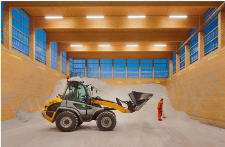
Das Gebäude besteht aus einer »Lagermulde« und einer darauf aufgesetzten »Wetterschutzhülle«. Holz und Stahlbeton, die Materialien der Tragkonstruktionen, sind jeweils dort eingesetzt, wo sie für die konstruktiv-statischen Erfordernisse die besten Eigenschaften bieten. So sind die Bauteile mit direktem Kontakt zum Salzklima des Innenraums in Holz ausgeführt, da Salz einen konservierenden Effekt auf Holz hat.
