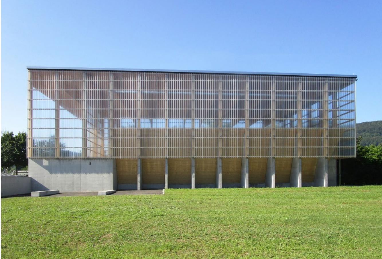
Die Konzeption und Konstruktion von neuen Salzlagerhallen muss vollständig aus den speziellen Anforderungen der Salzlagerung heraus entwickelt werden. Durch geänderte Logistik im Streusalzvertrieb wird eine lichte Durchfahrtshöhe von 10 Meter für Sattelschlepper mit gekippter Liefermulde erforderlich. Gleichzeitig erhöhen sich häufig aus Platzgründen auch die gewünschten Schütthöhen auf 5 bis 7 Meter.
