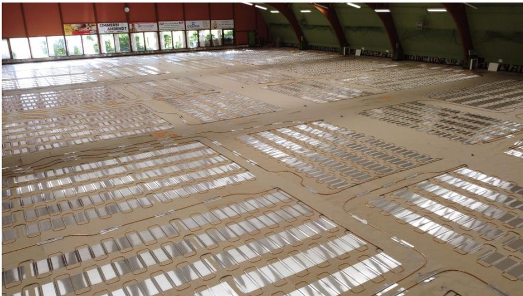
Große Zeitersparnis, die geringe Aufbauhöhe, keine Dehnungsfugen und eine einfache Verlegung bei hoher Heizleistung waren die entscheidenden Gründe, cufix® in Verbindung mit Gussasphalt einzusetzen. Außerdem weist der Gussasphaltestrich durch sein viskoelastisches Bindemittel Bitumen einen größeren Laufkomfort auf als andere Estricharten und sorgt in Kombination mit einer Fußbodenheizung für ein behagliches Raumgefühl.
