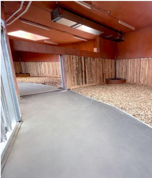
Im 600 Quadratmeter großen nichtöffentlichen Bereich mit Tierställen, Pflegergängen, Wirtschafts- und Funktionsräumen sowie dem Heulager liegt ein abgesandeter direkt genutzter Gussasphaltestrich AS IC 15. Dieser Gussasphalt eignet sich besonders für nicht beheizte Räume mit Temperaturen bis 0 °C. Darüber hinaus ist Gussasphalt wegen seiner hohen inneren Dämpfung der ideale Nutzbelag für Tiere.
