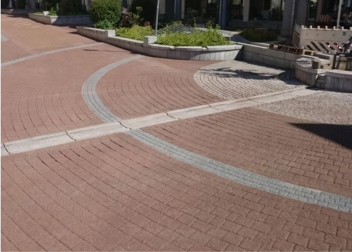
Ziel dieser Maßnahme war es, eine optisch ansprechende und hochwertige Deckschicht zu schaffen, die sich nahtlos in die vorhandenen Betonsteinpflasterflächen einfügt. Dank verschiedener Farbtöne gelang es, die ursprünglichen Muster der historischen Pflasterflächen detailgenau nachzubilden.
