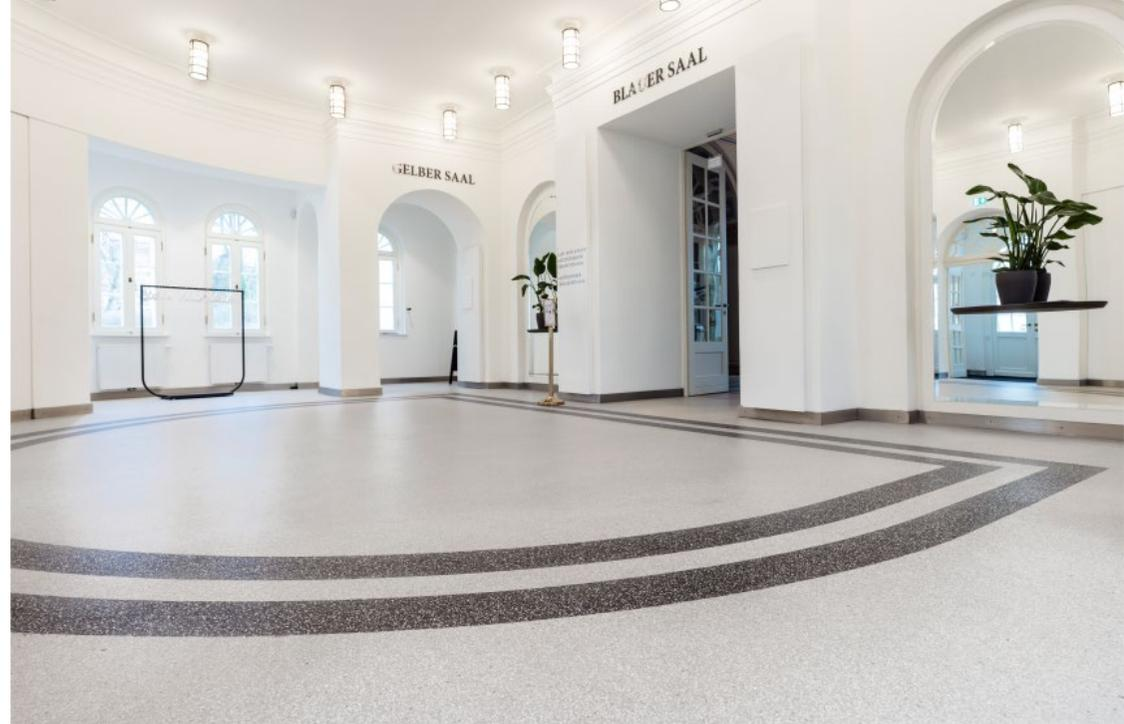
Um die Nutzung des Kellers zu erhalten, musste auf schlanke Bauteile für die Stahlbetondecke und den Bodenbelag geachtet werden. Nach Variantenprüfung fiel die Entscheidung der verantwortlichen Architekten STADT+HAUS auf einen geschliffenen Gussasphalt, da er eventuelle Durchbiegungen der Decke verträgt und bereits in anderen Projekten erfolgreich eingesetzt wurde.
