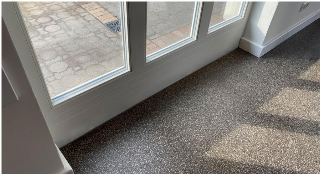
Besonderes Augenmerk gilt dem Bodenbelag aus geschliffenem Gussasphalt, der durch seine monolithische Struktur und hohe Langlebigkeit den intensiven Anforderungen des Schulalltags standhält. Der Belag ist pflegeleicht, emissionsarm und kann am Ende seines Lebenszyklus sortenrein getrennt und wiederverwendet werden – ein Beitrag zur nachhaltigen Materialkreislaufwirtschaft, die das ökologische Gesamtkonzept des Projekts abrundet.
